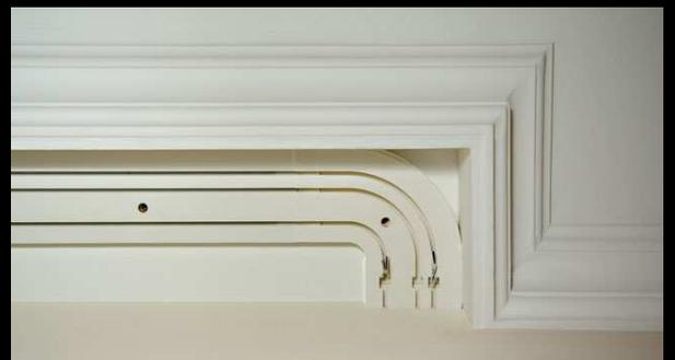
Für den Fall, dass die Stoffblende direkt an der Gardinenschiene mit einem Klettband befestigt werden soll, müsste dann die Holzblende von 80x9mm mit kleinen Metall-Winkeln in entsprechendem Abstand zur Gardinenschiene direkt an der Decke befestigt werden um so die Stabilität der Stuckleiste zu gewährleisten. Diese Art der Verblendung ist auch mit den anderen Leistenarten möglich.
